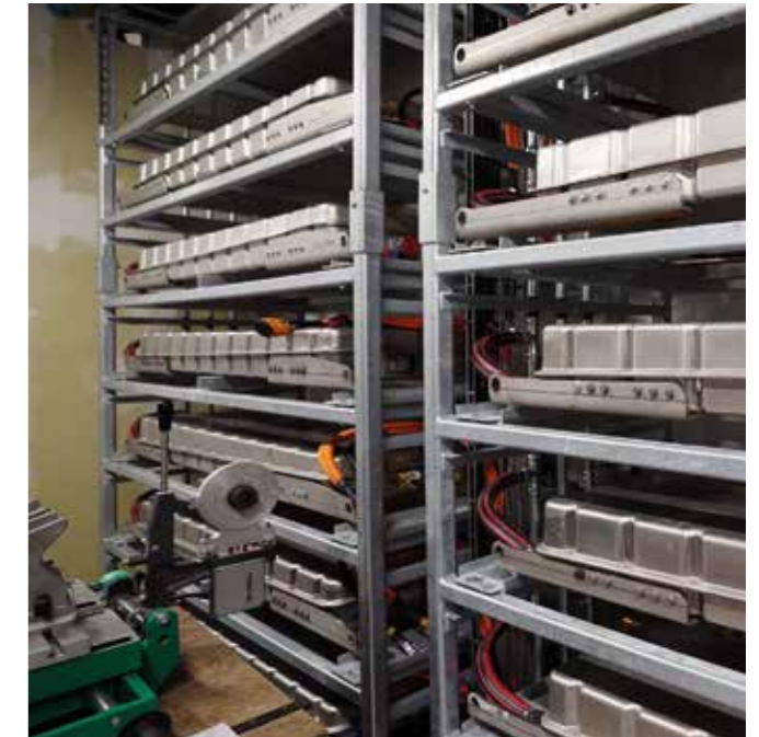
Im Einsatz: Hier dienen sie als Strom-Zwischenspeicher.
