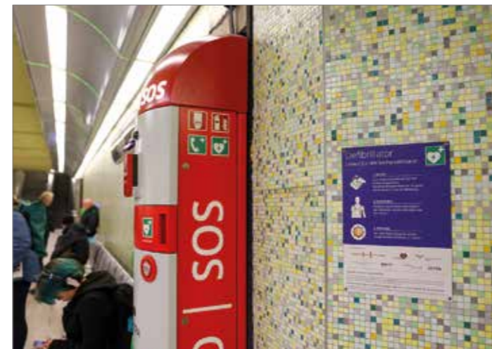
Die Säule, die hilft: Neue Notruf- und Informationssäulen
