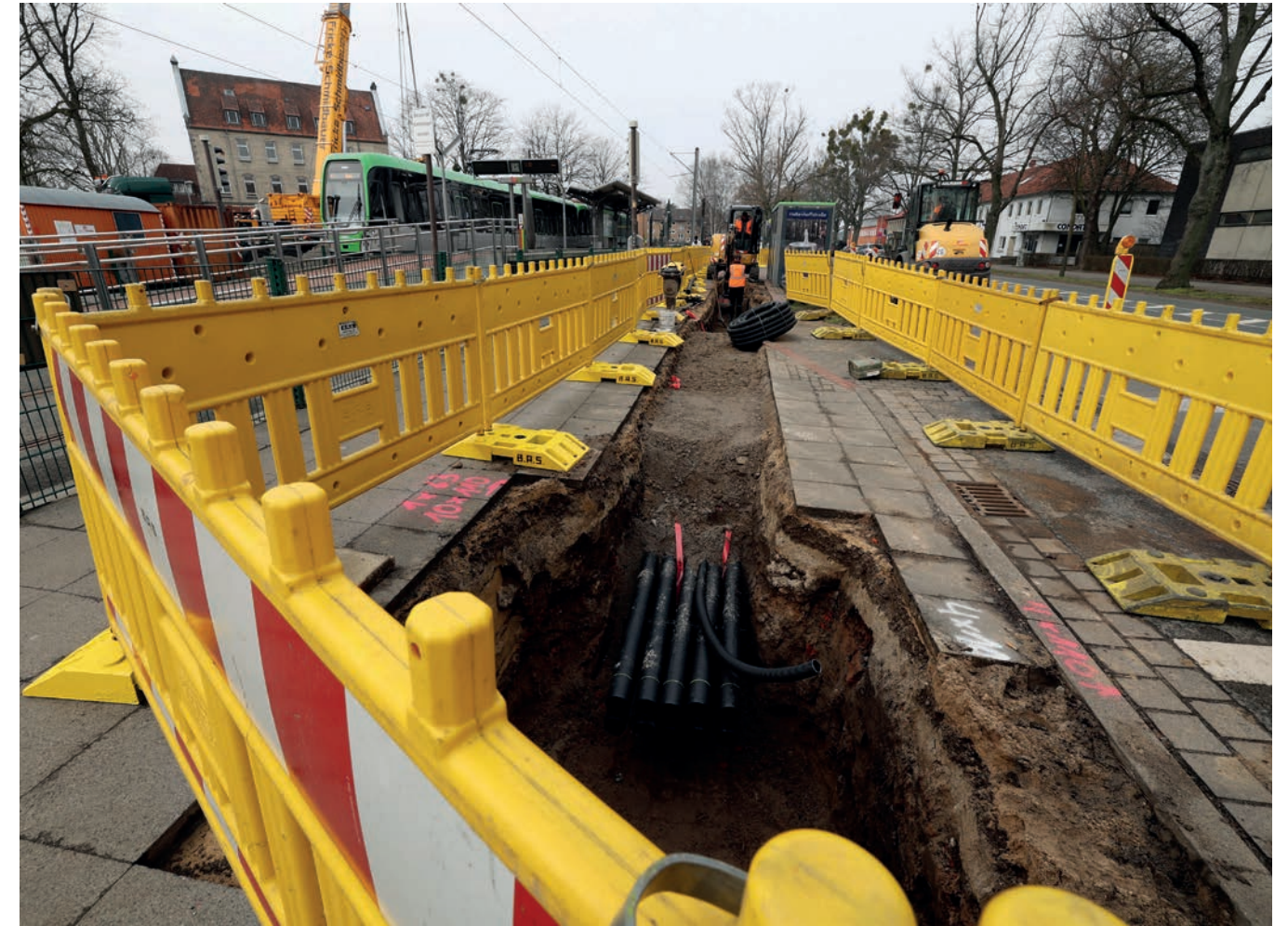
Bevor ein Lademast aufgestellt werden kann, sind vor allem vorbereitende Leitungsarbeiten notwendig.
