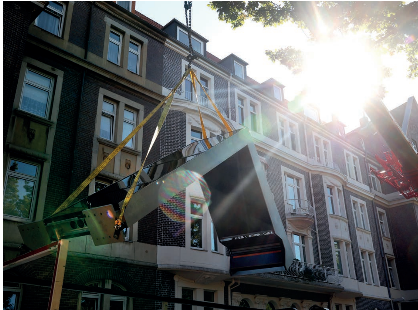
Ein beeindruckendes Bild: Der Lademast wird per Kran eingesetzt.
