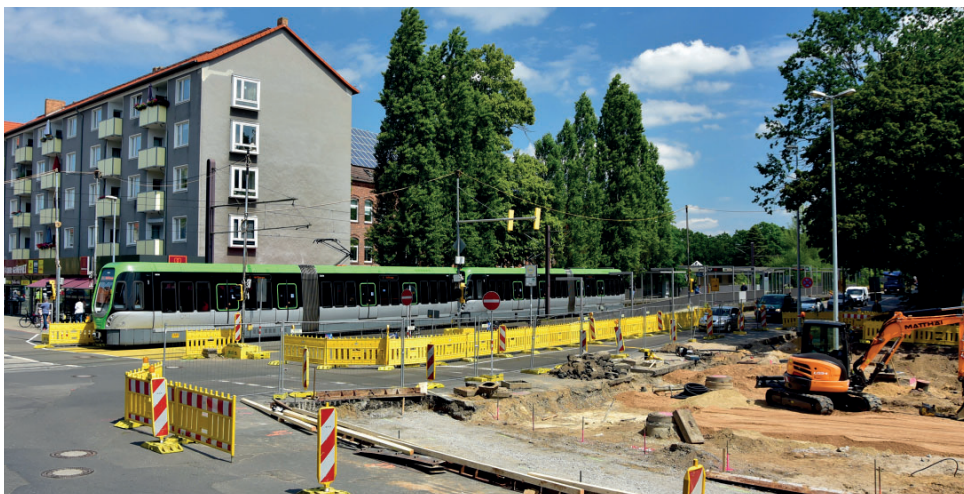
An der Wallensteinstraße sind die Baumaßnahmen in vollem Gange.
